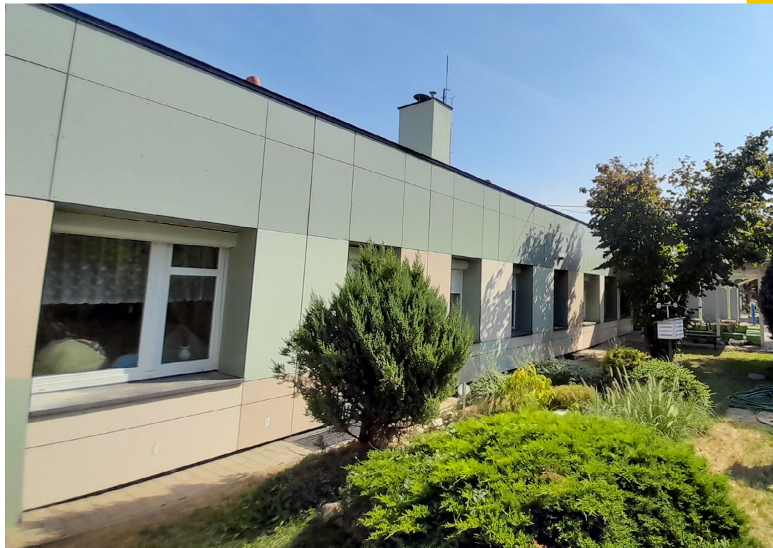
A Zöld Liget Óvoda homlokzata hőszigetelés után
