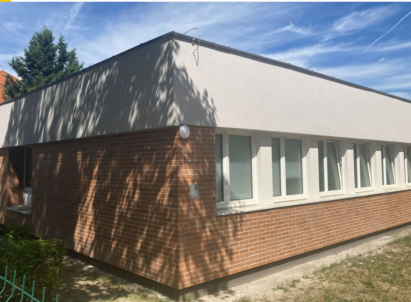
Albertfalvi gyermekorvosi rendelő homlokzati szigetelése
