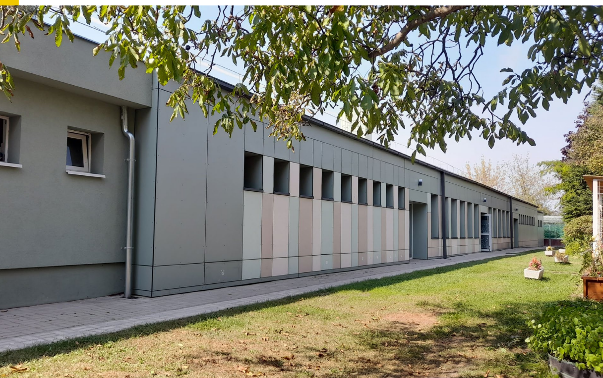
A Zöld Liget Óvoda homlokzata hőszigetelés után
